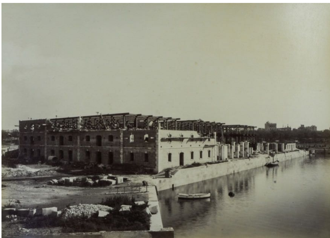
Fig. 6 Construcció del Dipòsit Comercial (Fotografia de Pau Audouard, 1896)
